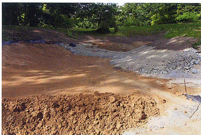
Bei der Wiederherstellung des Schwarzes Meeres galten strenge Denkmalschutzvorgaben. Die Landschaftsgärtner verwendeten eine Tonabdichtung und verzichteten auf Teichfolie.
