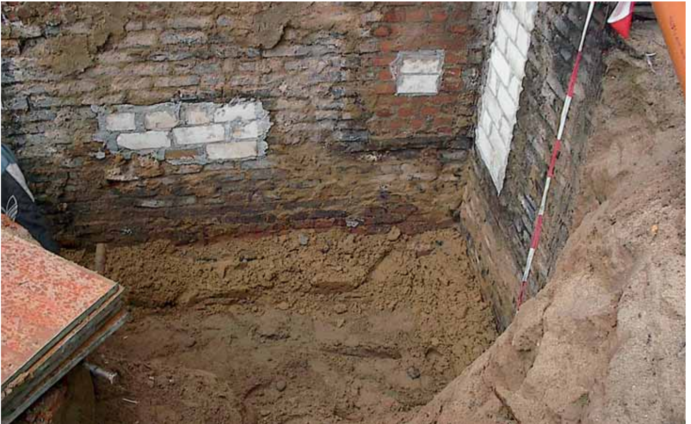
Die TonSandMischung benötigt keine Bitumenmischung sondern wird direkt am Mauerwerk verarbeitet. Es setzt sich in dessen Zwischenräume
