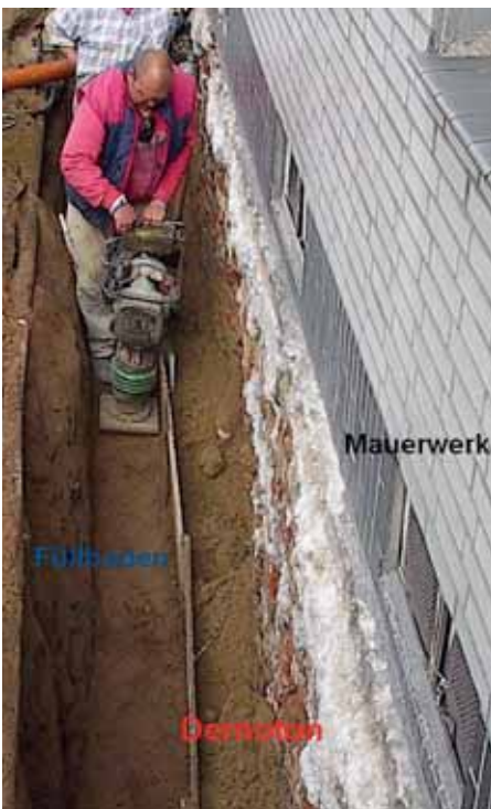
Die Fertigmischung wird direkt an die Mauer gebracht
