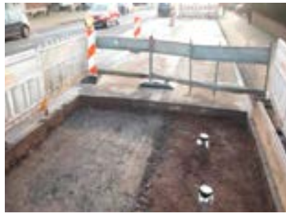
... und nach dem Einfüllen des Baumsubstrates
