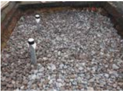
Pflanzbeet nach dem Einfüllen der Eifellava ...
