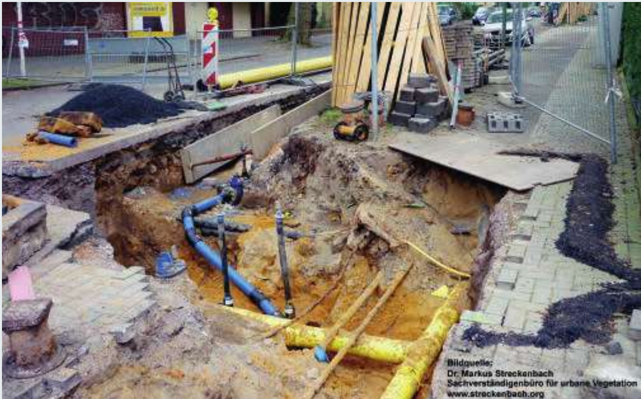
Bild 2: Aufgrabung in Bochum mit typischer Situation vor Ort: Der Leitungsgraben im Straßenraum ist durch verschiedene Leitungen belegt. Es entsteht eine Konkurrenzsituation mit der Baumvegetation
