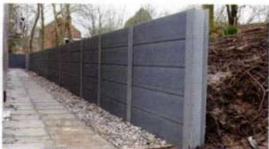
TRIMAX als Böschungssicherung
