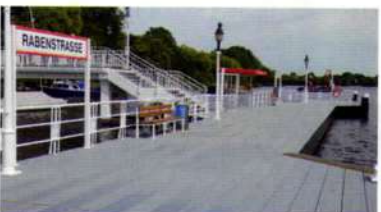
TRIMAX für eine Terrasse
