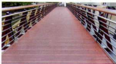
TRIMAX als Brückenbelag
