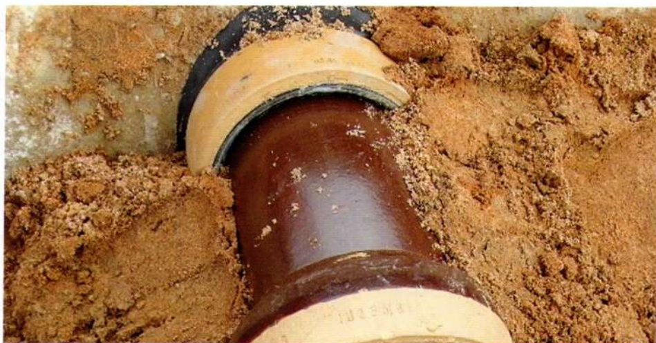
Mineralische Kapselung einer Rohrleitung mit Dertonon-Fertigmischung. | Foto: Dernbach
