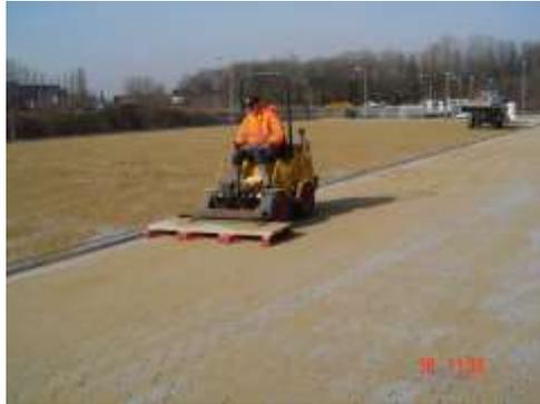
Es hat sich als vorteilhaft herausgestellt, dass die obersten 2 – 3 cm Fugenhöhe mit "normalem Fugensand" o.ä. verfüllt werden, um ein Herausquellen der DERNOTON®-Fertigmischung F zu verhindern.
